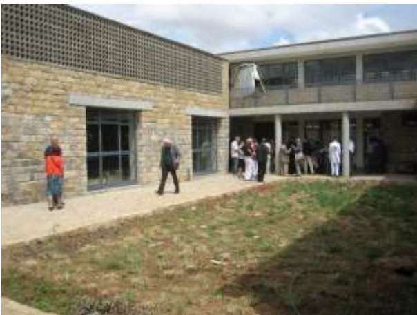
Der Innenhof mit Magazin/Werkstatt links und dem Verwaltungsgebäude mit Ausstellungsraum für temporäre Ausstellungen und archäologischen Archivräumen
