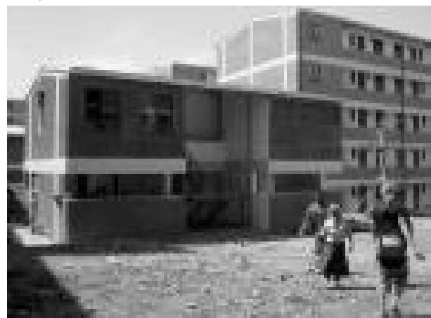
Abb. 2: Neubauprojekt mit „Communal House“
